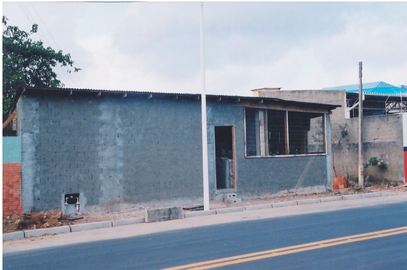
Fotografia 12: abatedouro - 2ª Fase - fachada
